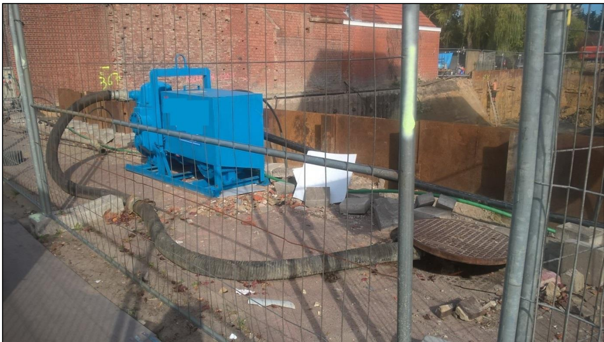
Figuur 58 bemaling met lozing van het bemalingswater, echter zonder de wettelijk vereiste debietmeter
