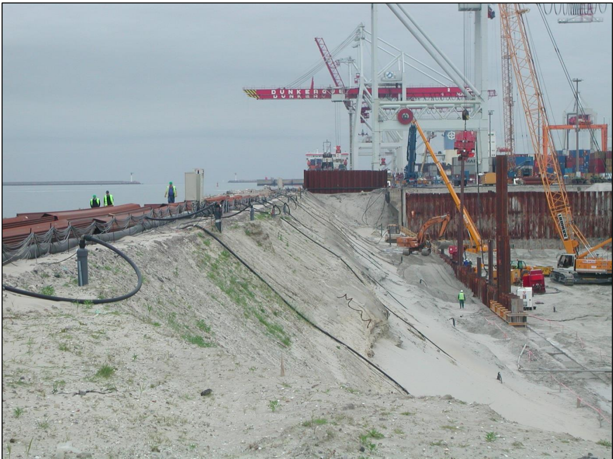
Figuur 32 uitvoering van een bemaling met dieptebronnen
