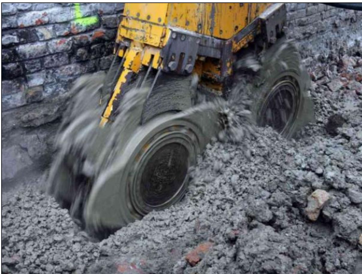
Figuur 65 frezen van een soilmixwand type 2 (bron: Lameire)
