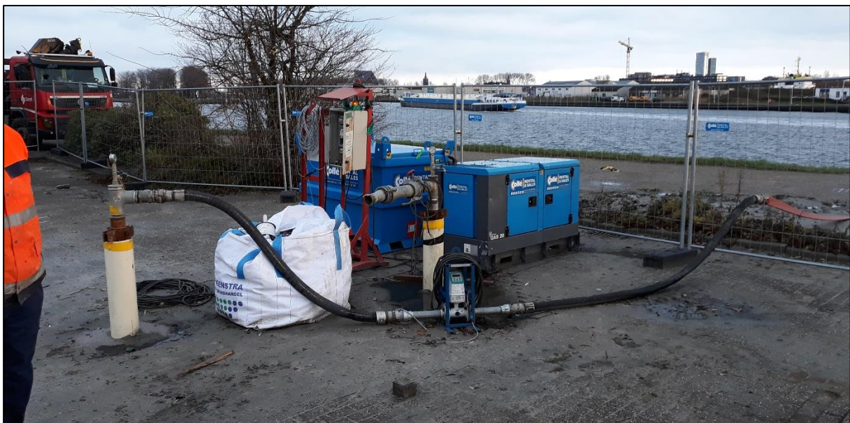
Figuur 56 correct opgestelde EM debietmeter (witte pijl) op een onderwaterpomp. Let op het leidingwerk voor en voorbij de debietmeter en de verhoogde afvoer voorbij de debietmeter.
